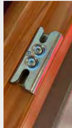
Gâche anti-arrachement protège contre les effractions (en STD)
